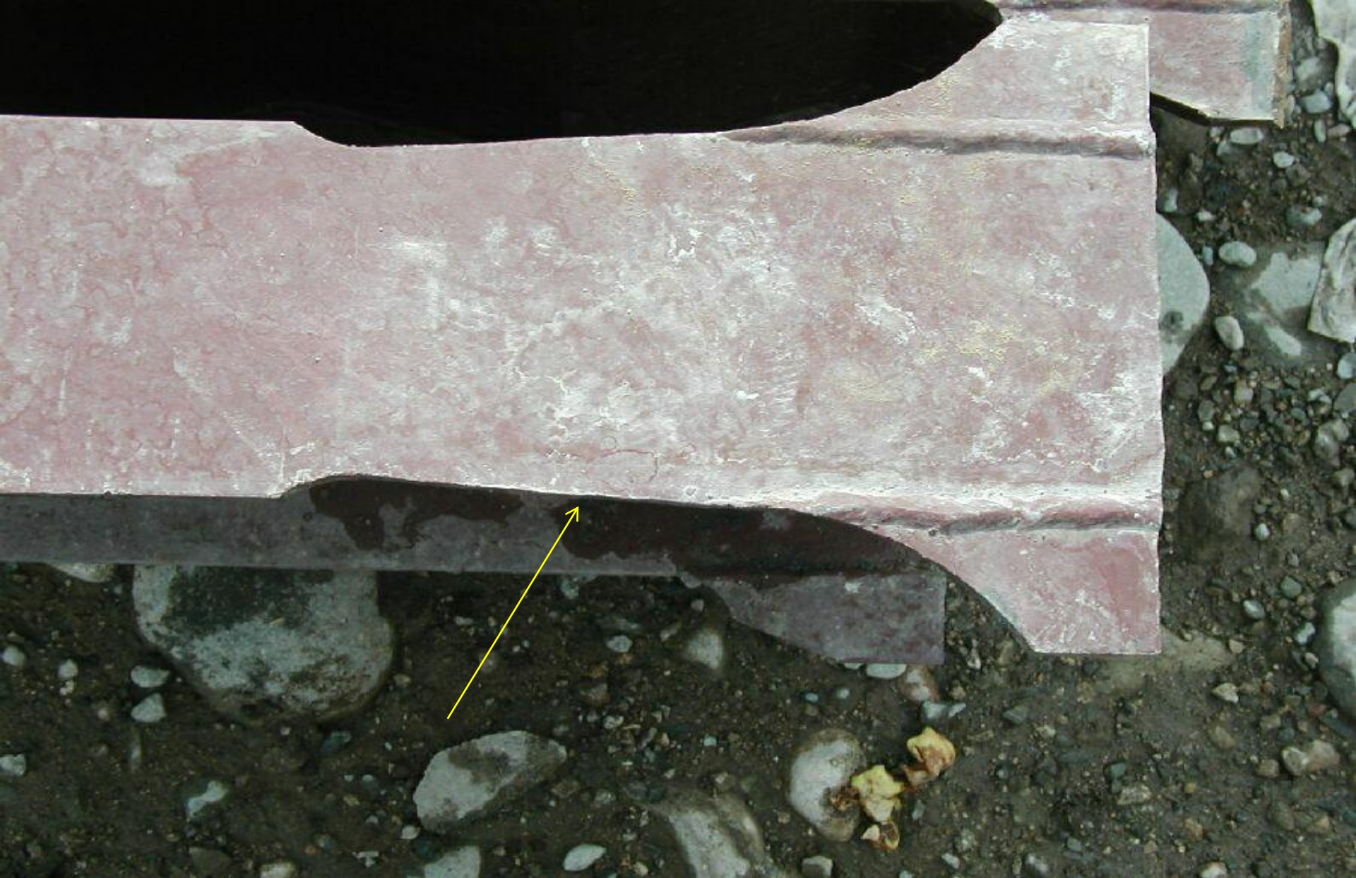
Пояс ригеля с зоной равного сопротивления (указано стрелкой)
