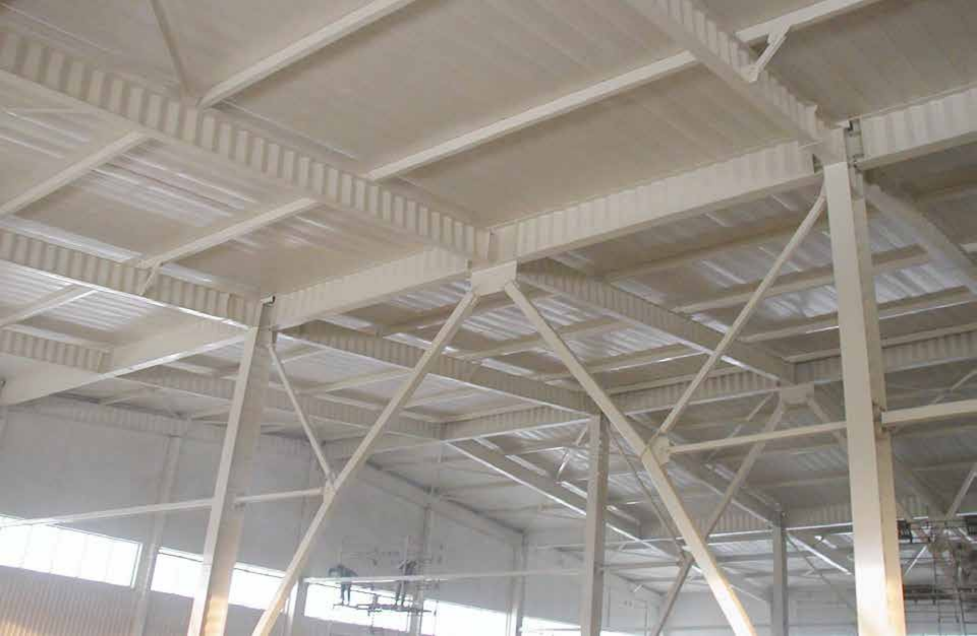
2007 год. Склад готовой продукции в г. Алматы. Фрагмент покрытия склада
