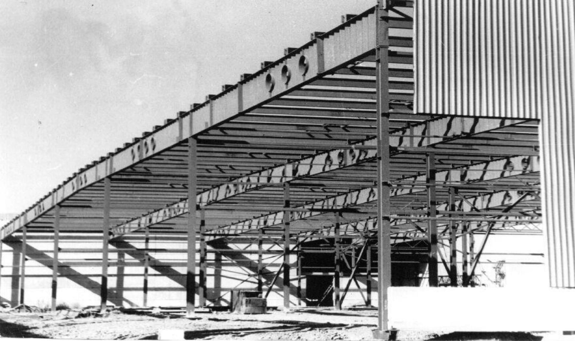
1985 год. Покрытие одного из цехов производственного корпуса в г. Караганде. Стропильные балки пролетом 24,0м, высота 1500мм, толщина стенок 4,0мм. Экономия стали на весь корпус в сравнении с первоначальным проектом 147т (17%)
