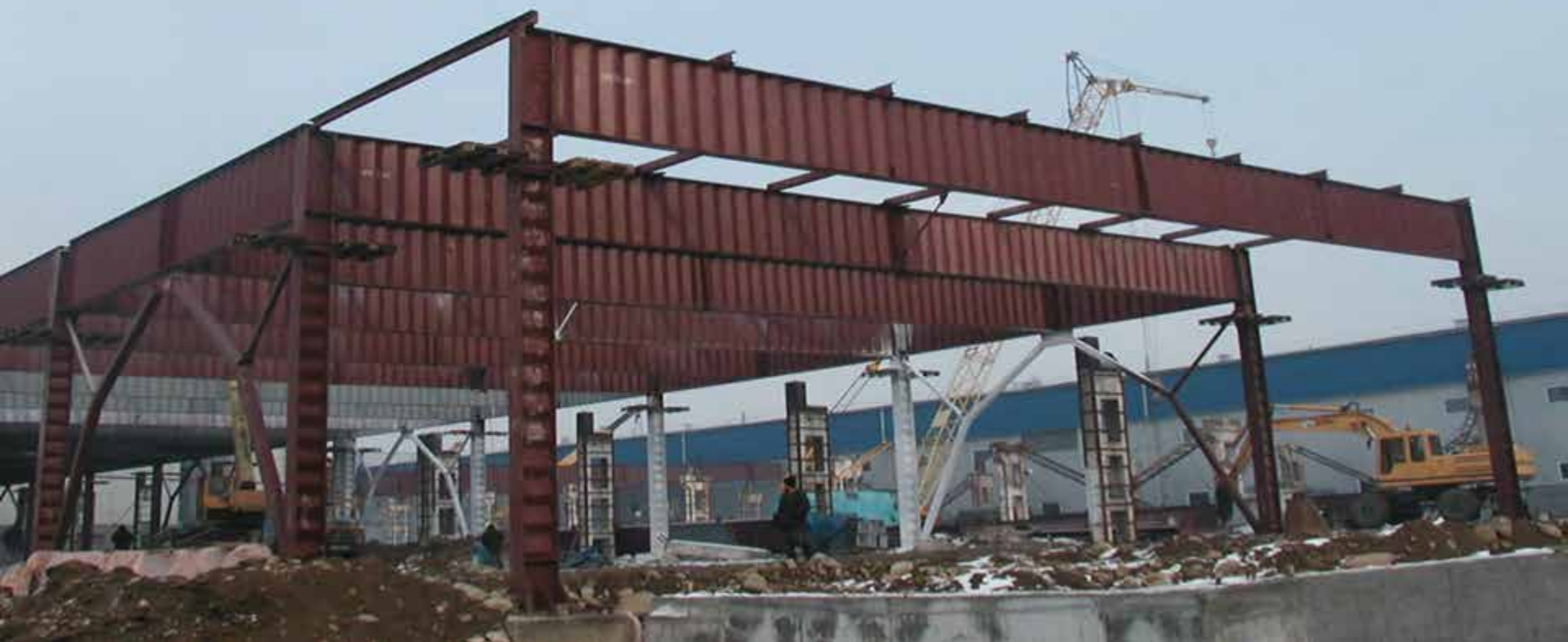
Одноэтажное производственное здание в г. Алматы. Колонны и ригели выполнены с гофрированными стенками толщиной 4мм. Пролет ригеля 24,0 м, высота сечения ригеля 1500 мм. Высота сечения колонны 450 мм. Экономия стали 20%. Фото января 2005 года
