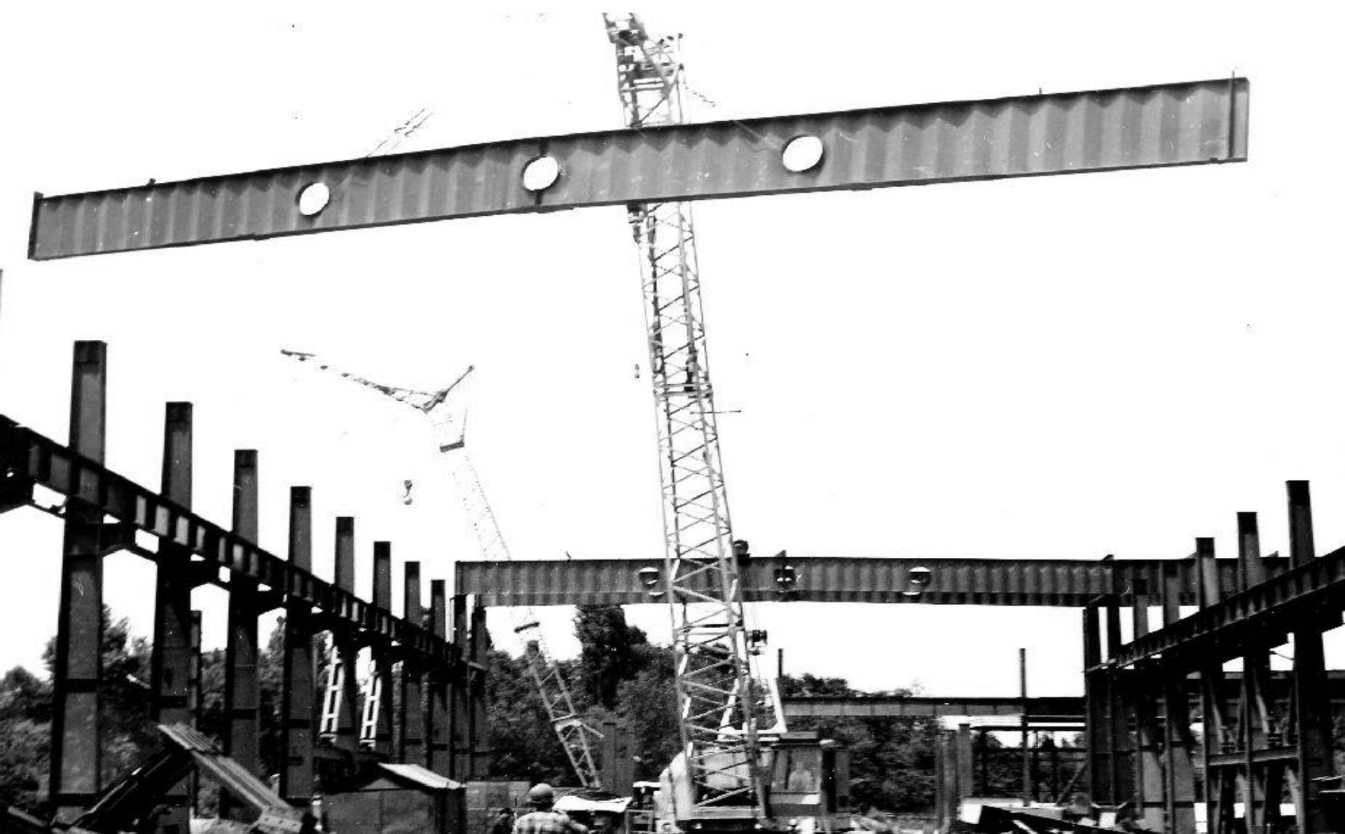
1982 год. Покрытие производственного корпуса в г. Алма-Ате. Монтаж стропильных балок с тонкими гофрированными стенками пролетом 24,0м
