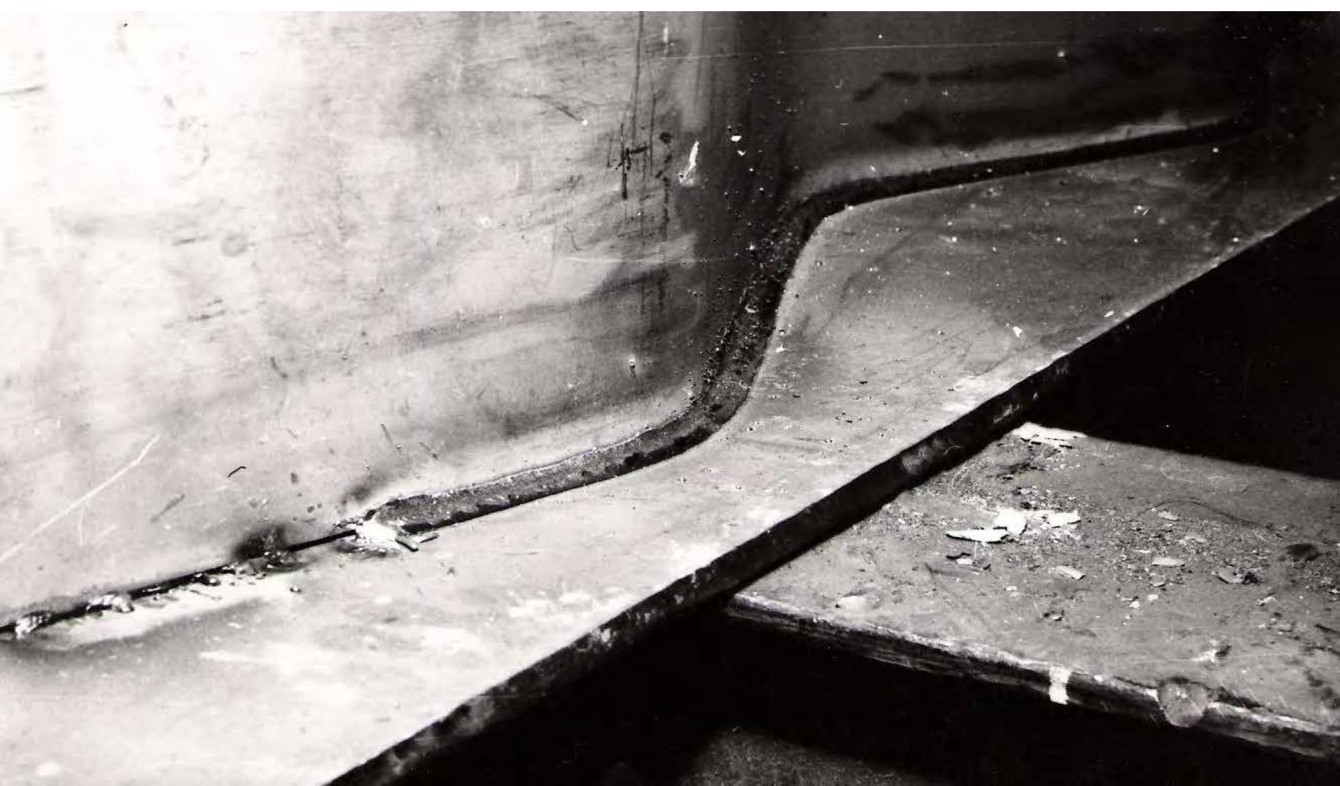
Поясной шов балки с гофрированной стенкой сваренный автоматом г. Джамбуле
