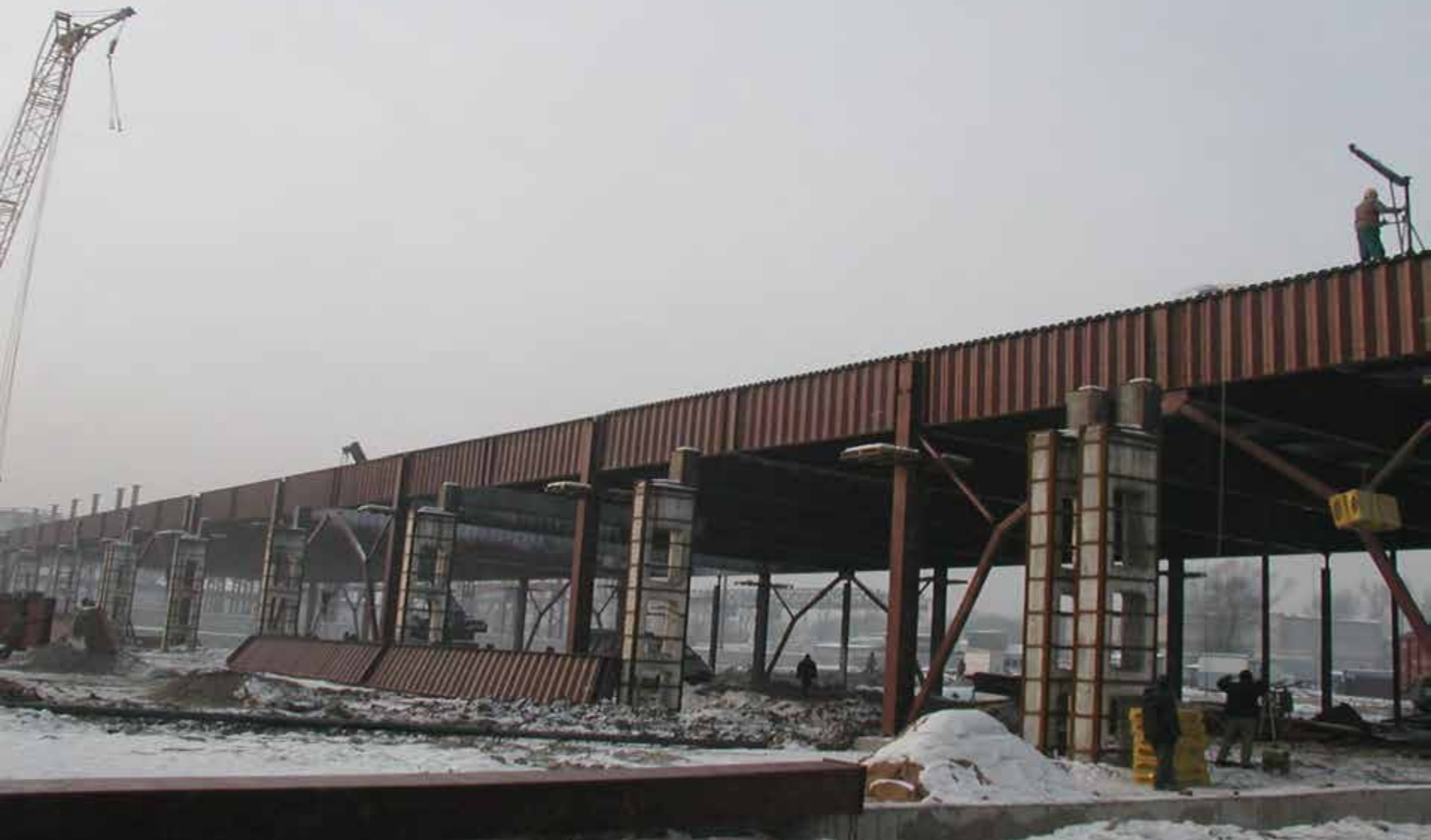
Одноэтажное производственное здание в г. Алматы. Колонны и ригели выполнены с гофрированными стенками толщиной 4мм. Фото января 2005 года вдоль здания
