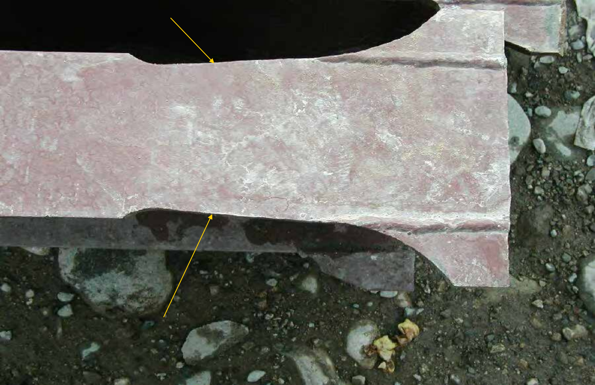
Пояс ригеля с зоной равного сопротивления (указано стрелками)
