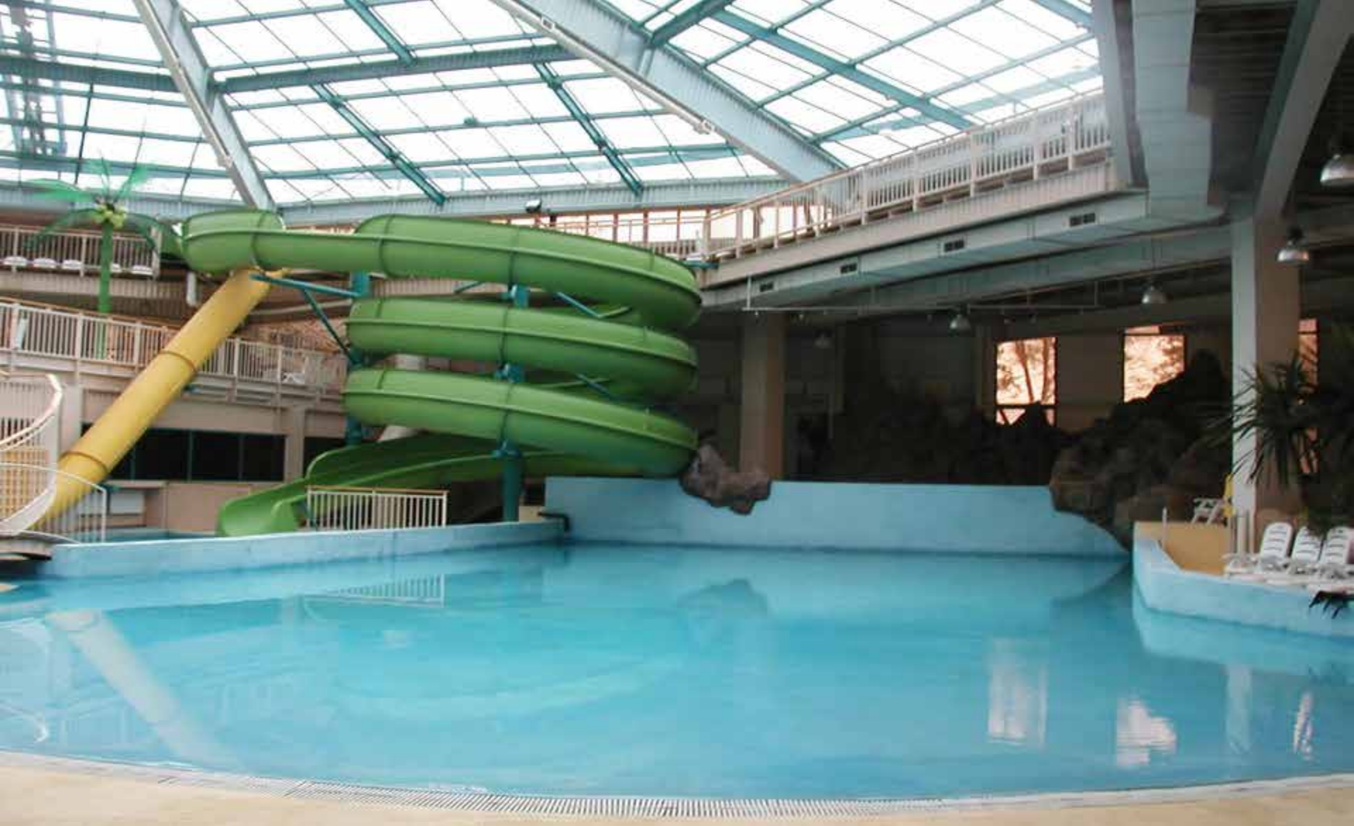
Здание аквапарка в г. Алматы. Колонны и балки покрытия с гофрированными стенками толщиной 4 мм
