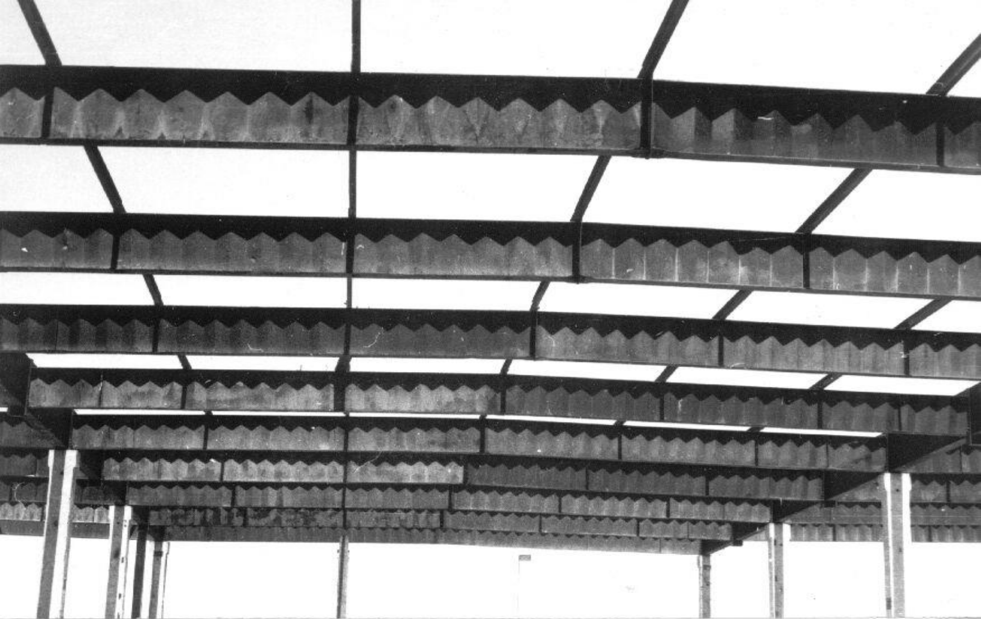
1983 год. Фрагмент покрытия производственного здания в Алма-Атинской обл. Стропильные балки пролетом 18,0м, высота стенки 900мм, толщина 3мм
