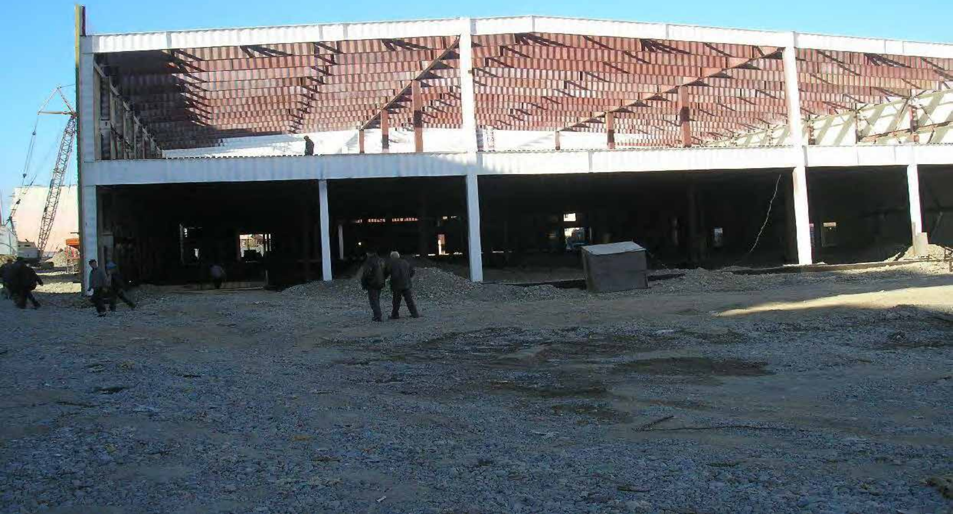
2007 год. г. Талдыкорган Алматинской области. Торгово-развлекательный центр «Сити Плюс». Фрагмент каркаса - Торцовая рама по оси «14».
