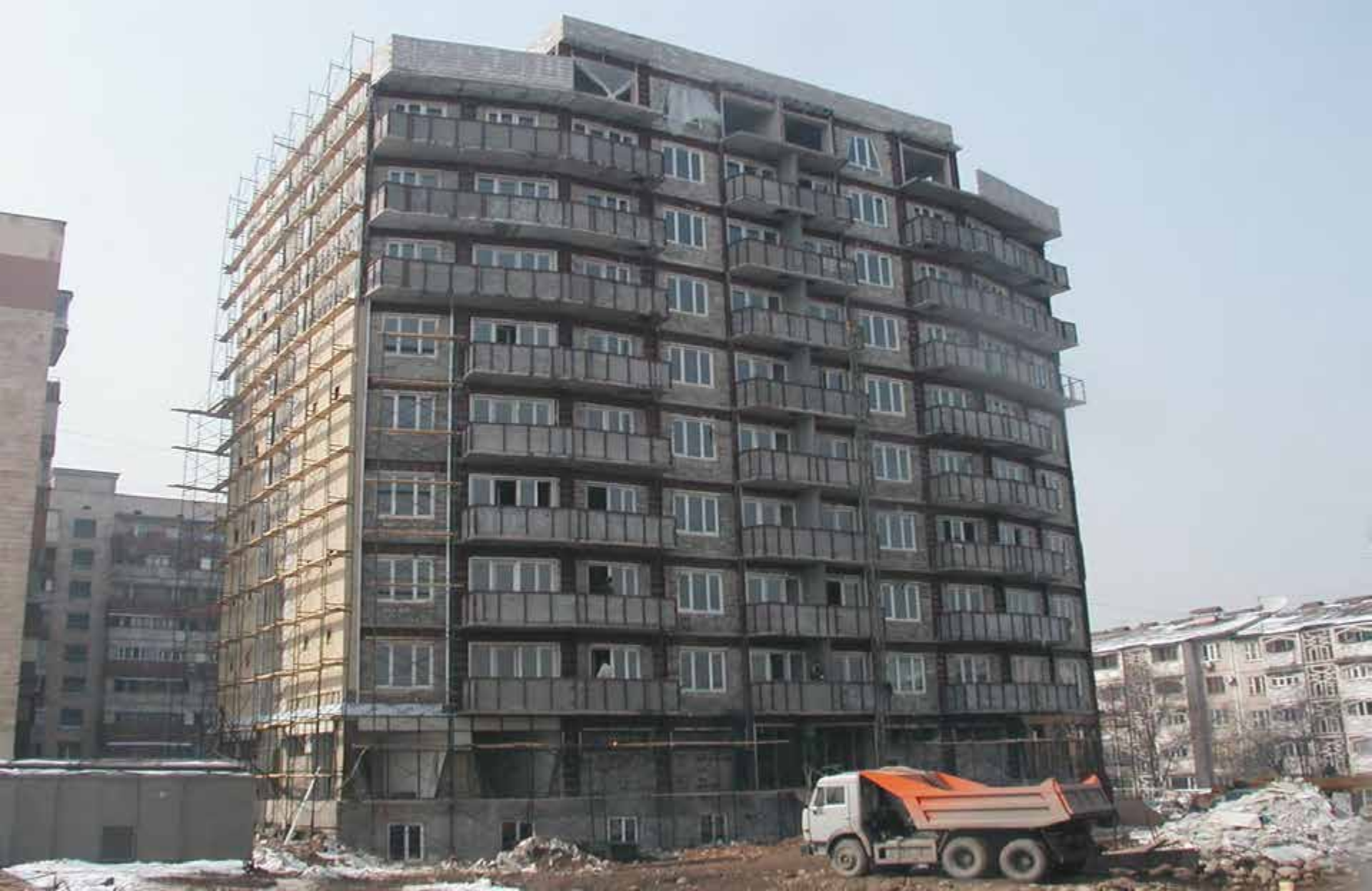
2007 год. г. Алматы. Многоэтажный жилой дом со стальным каркасом, в котором колонны и ригели выполнены с гофрированными стенками. Экономия стали 18 % по сравнению с каркасом с плоскими стенками
