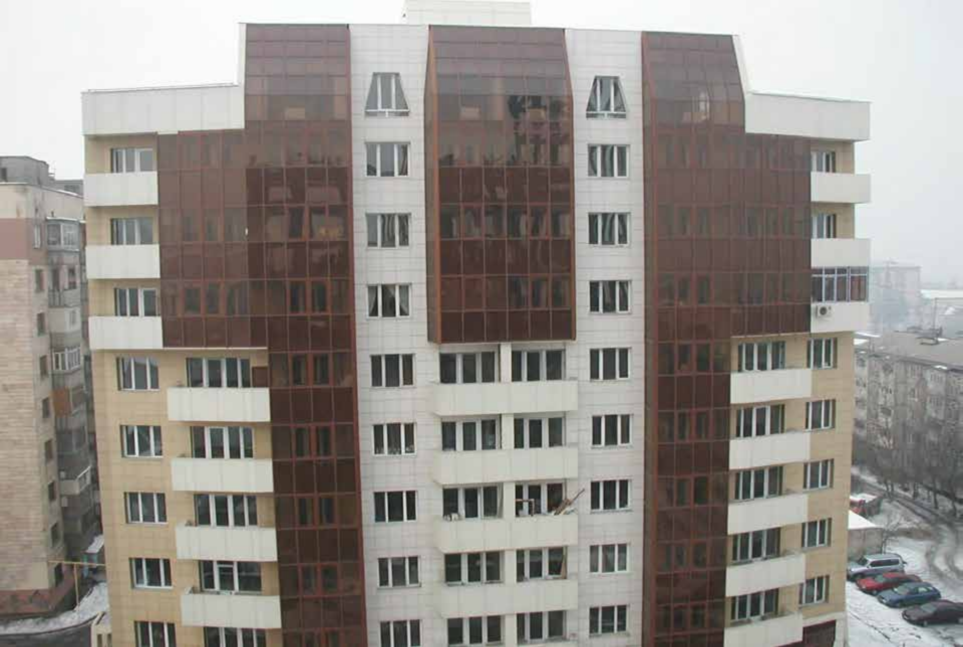
2007 год. г. Алматы. Многоэтажный жилой дом со стальным каркасом, в котором колонны и ригели выполнены с гофрированными стенками.
