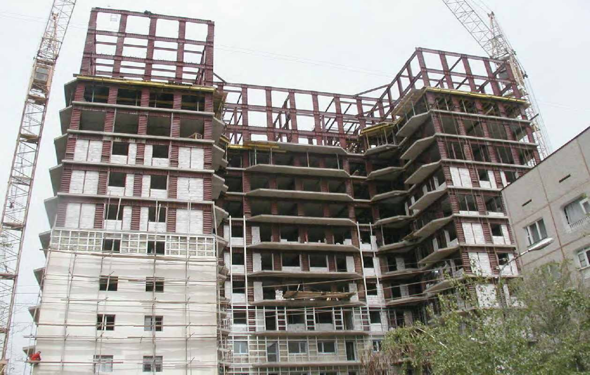
2005 год. г. Алматы. Первый в мире стальной каркас многоэтажного здания с колоннами и ригелями двутаврового сечения с гофрированными стенками
