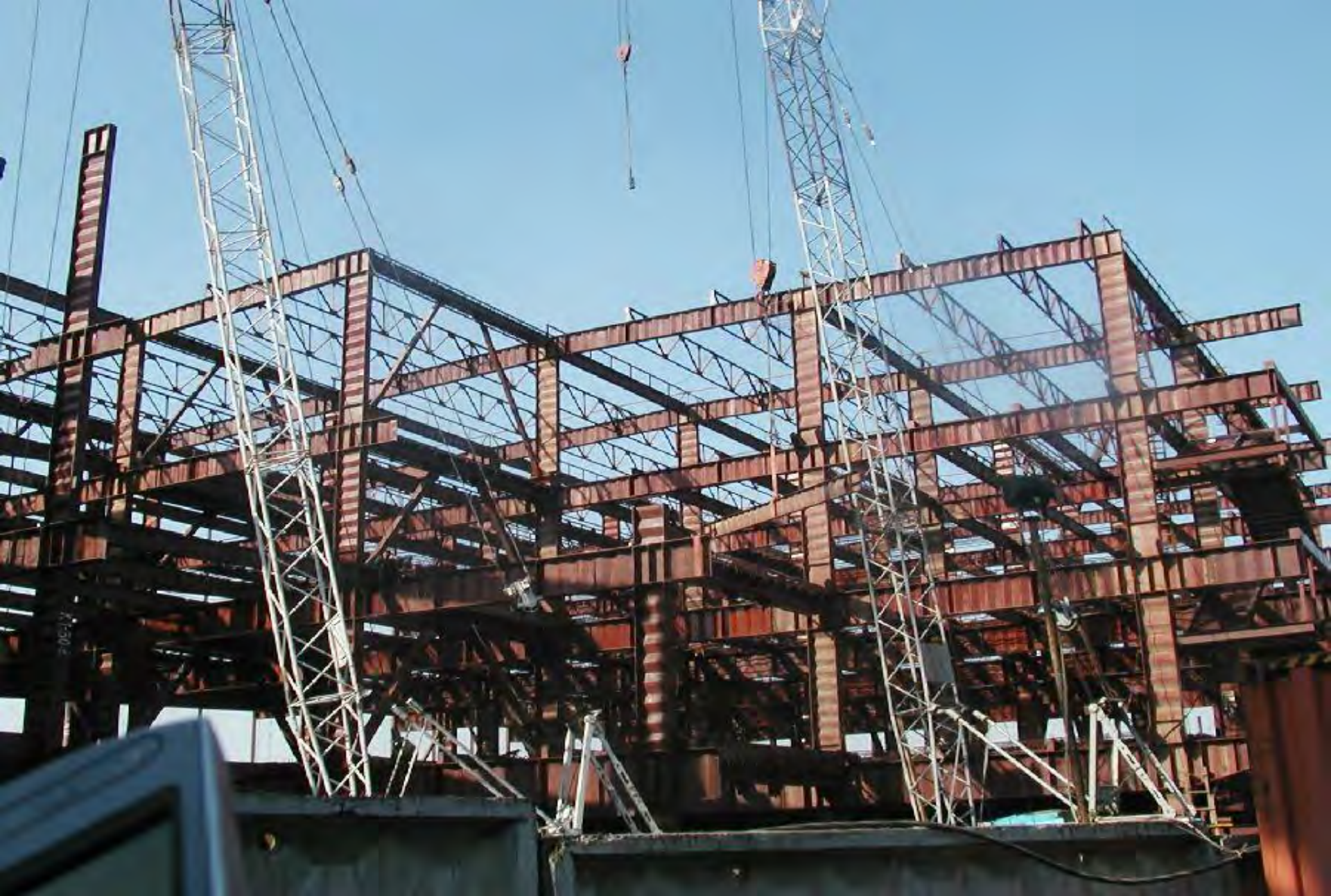
г. Алматы. 2007 год. Многофункциональное здание с двухэтажным автопаркингом
