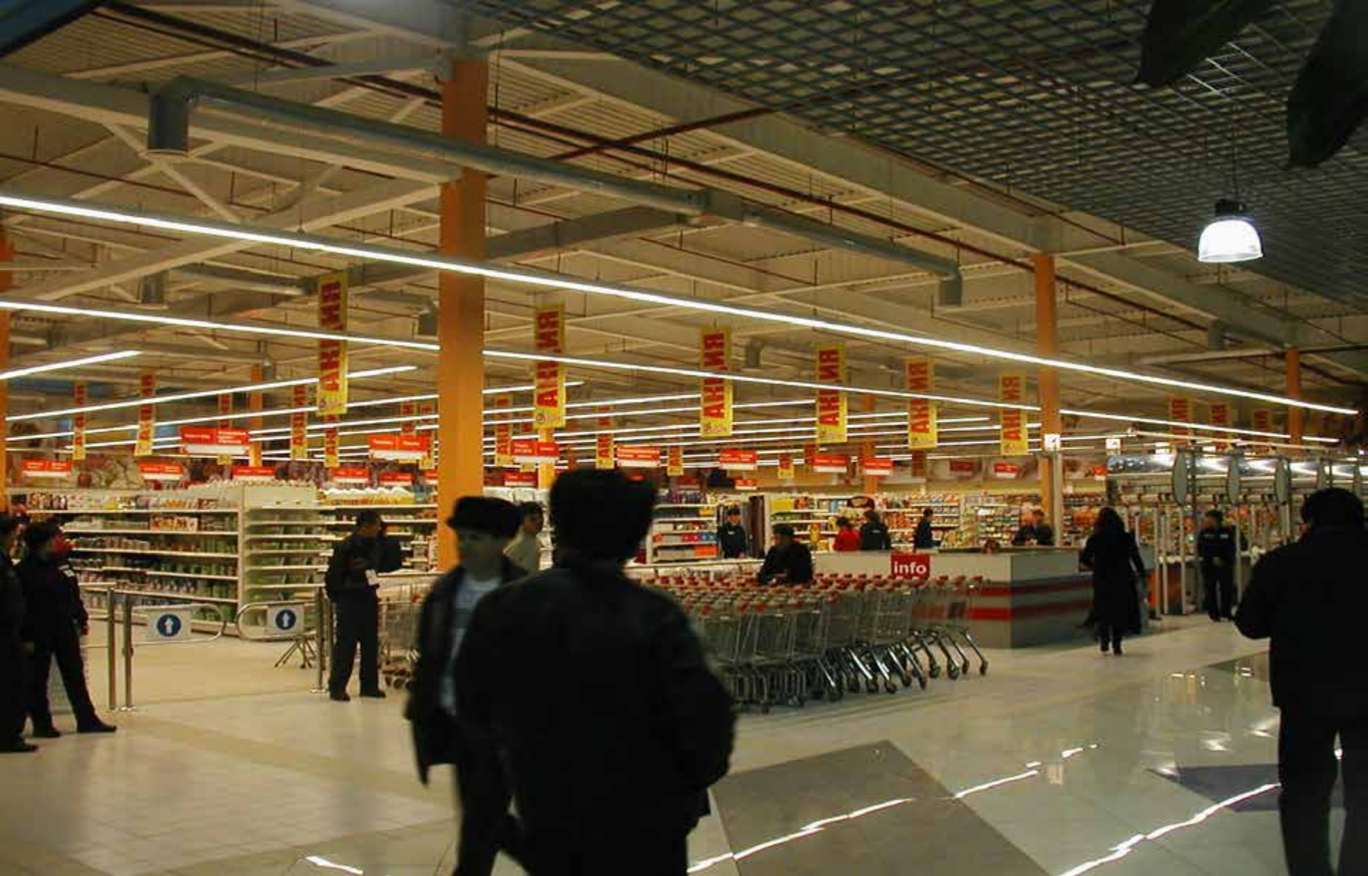
2007 год. г. Капшагай Алматинской области. Торговый центр «СИТИ ПЛЮС». Стропильные балки покрытия и колонны по наружным осям выполнены сварного двутаврового сечения с гофрированными стенками
