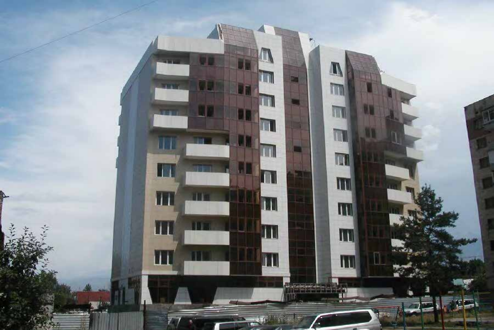
2007 год. Г. Алматы. 9-ти этажное здание с м/к каоркасом из двутавров с гофрированными стенками
