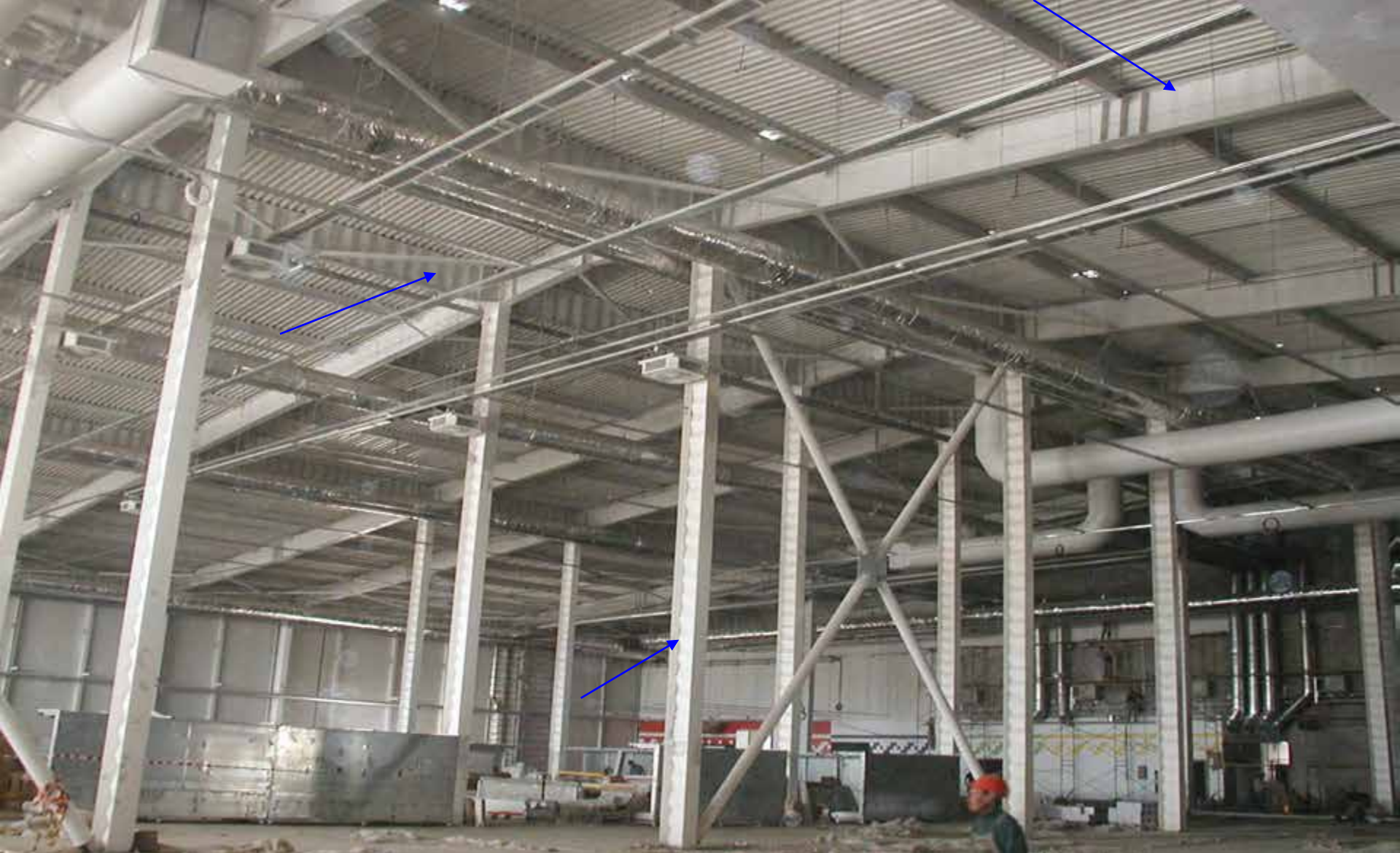
г. Алматы. 2008 год. Площадка 9 баллов. Фрагмент центрального зала Торгового центра. Колонны и ригели выполнены из сварных двутавров с гофрированными стенками
