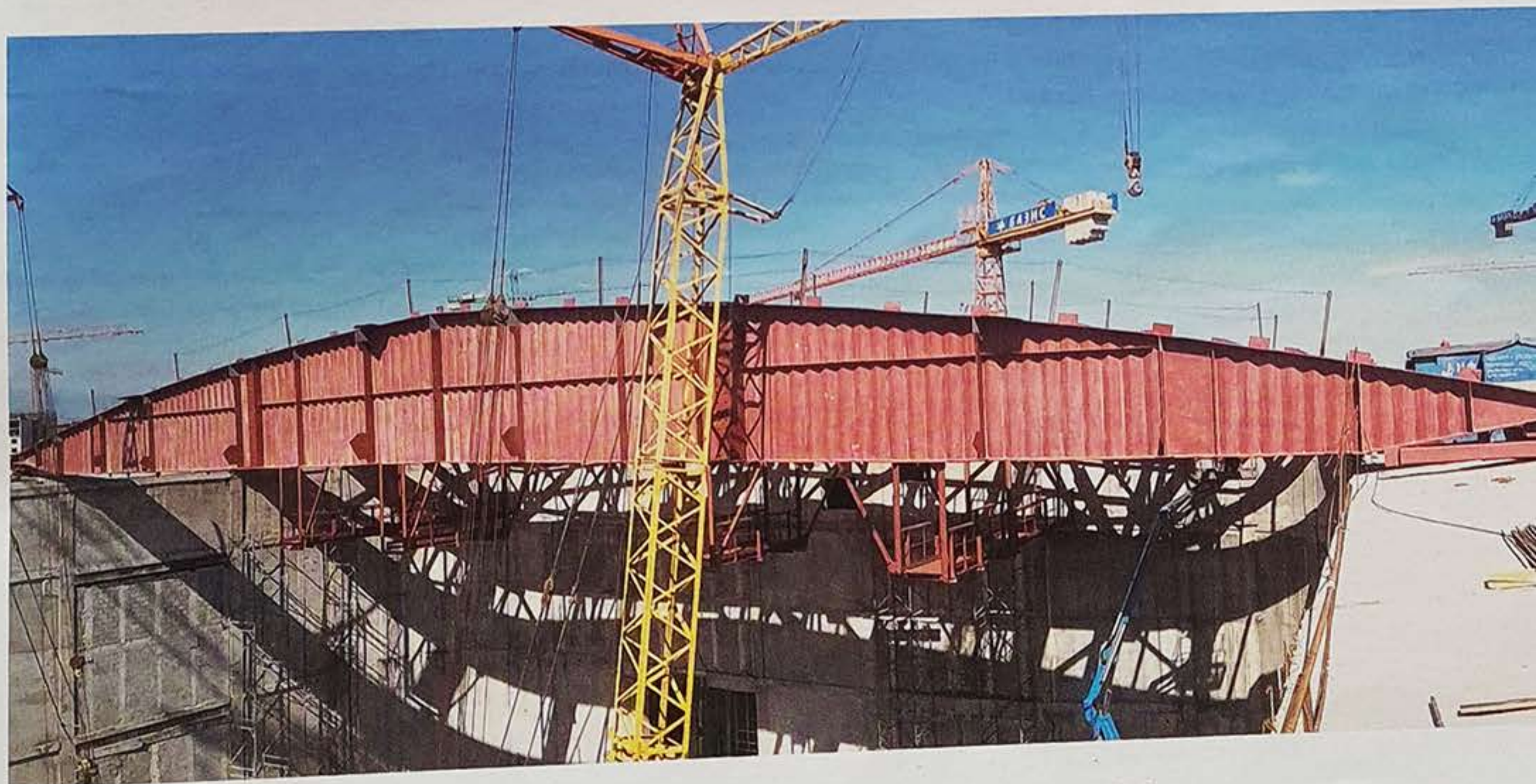
Рисунок 9 — Стропильная балка Блока Б пролетом 51,6 м
