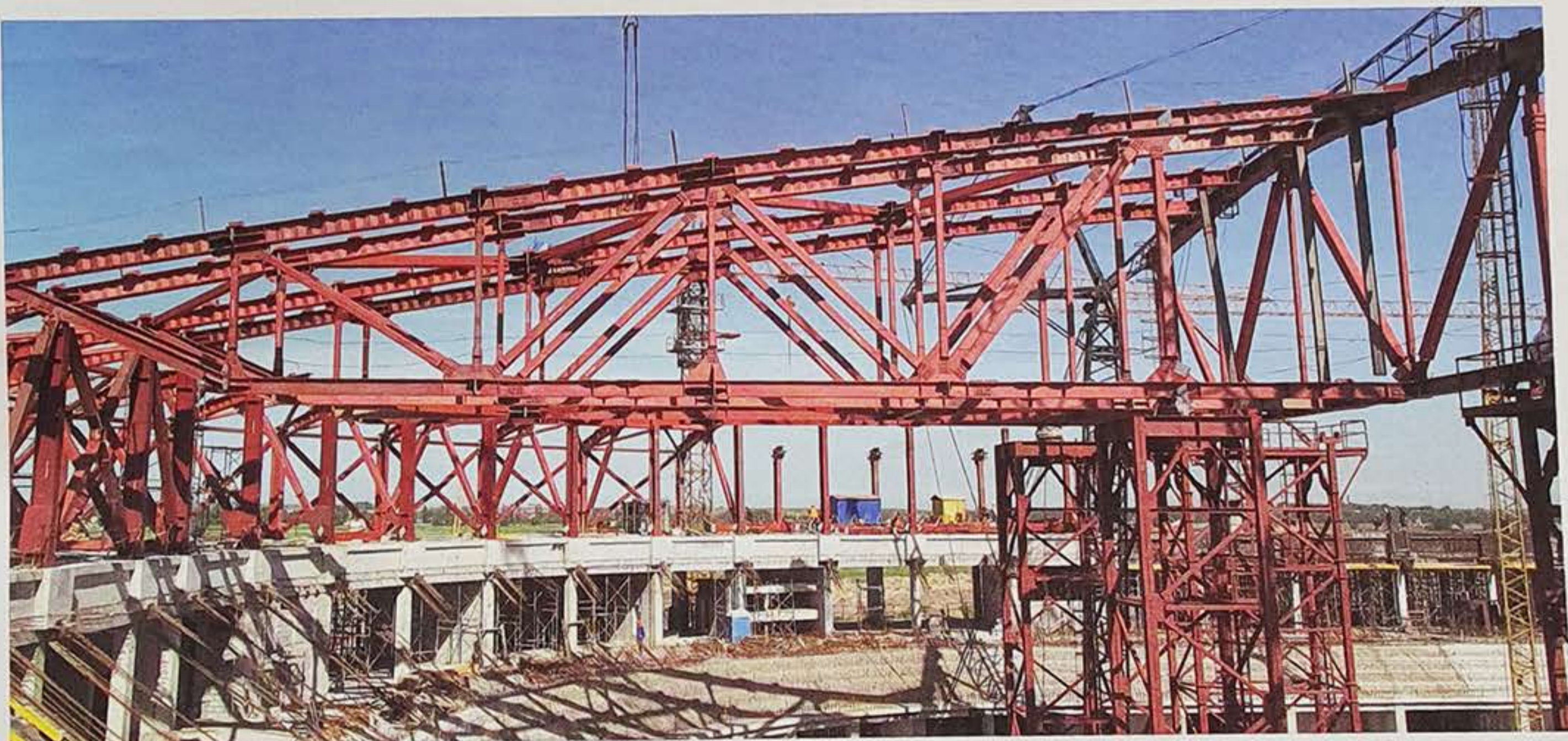
Рисунок 4 — Смонтированные стропильные фермы пролетом 37,0 м
