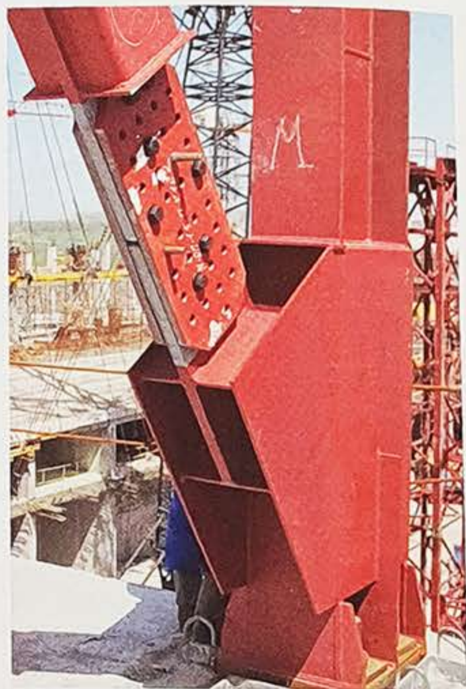
Рисунок 7 — Конструкция сдвигового энергопоглотителя в подкосных связях
