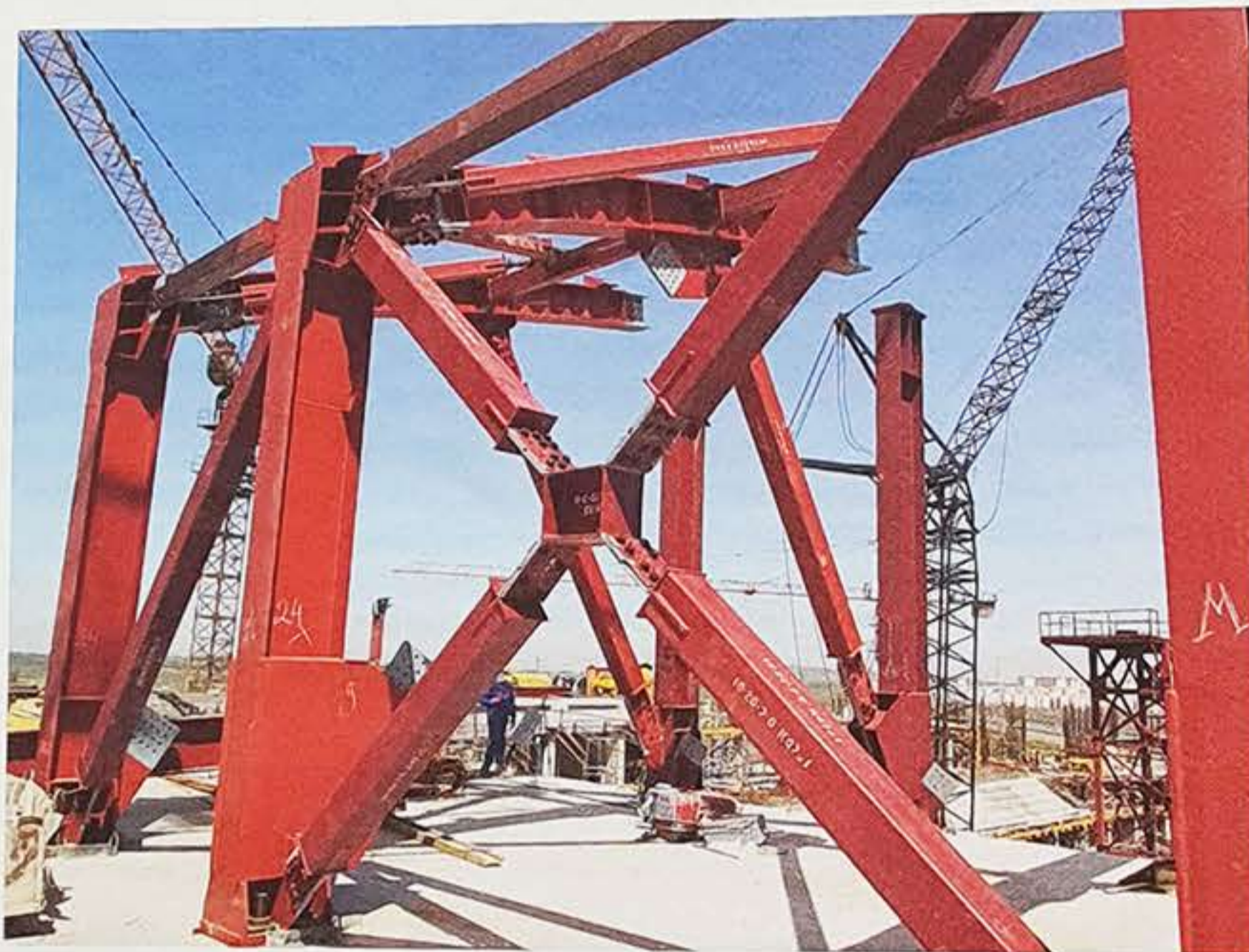
Рисунок 6 — Конструкция сдвигового энергопоглотителя в крестовых связях
