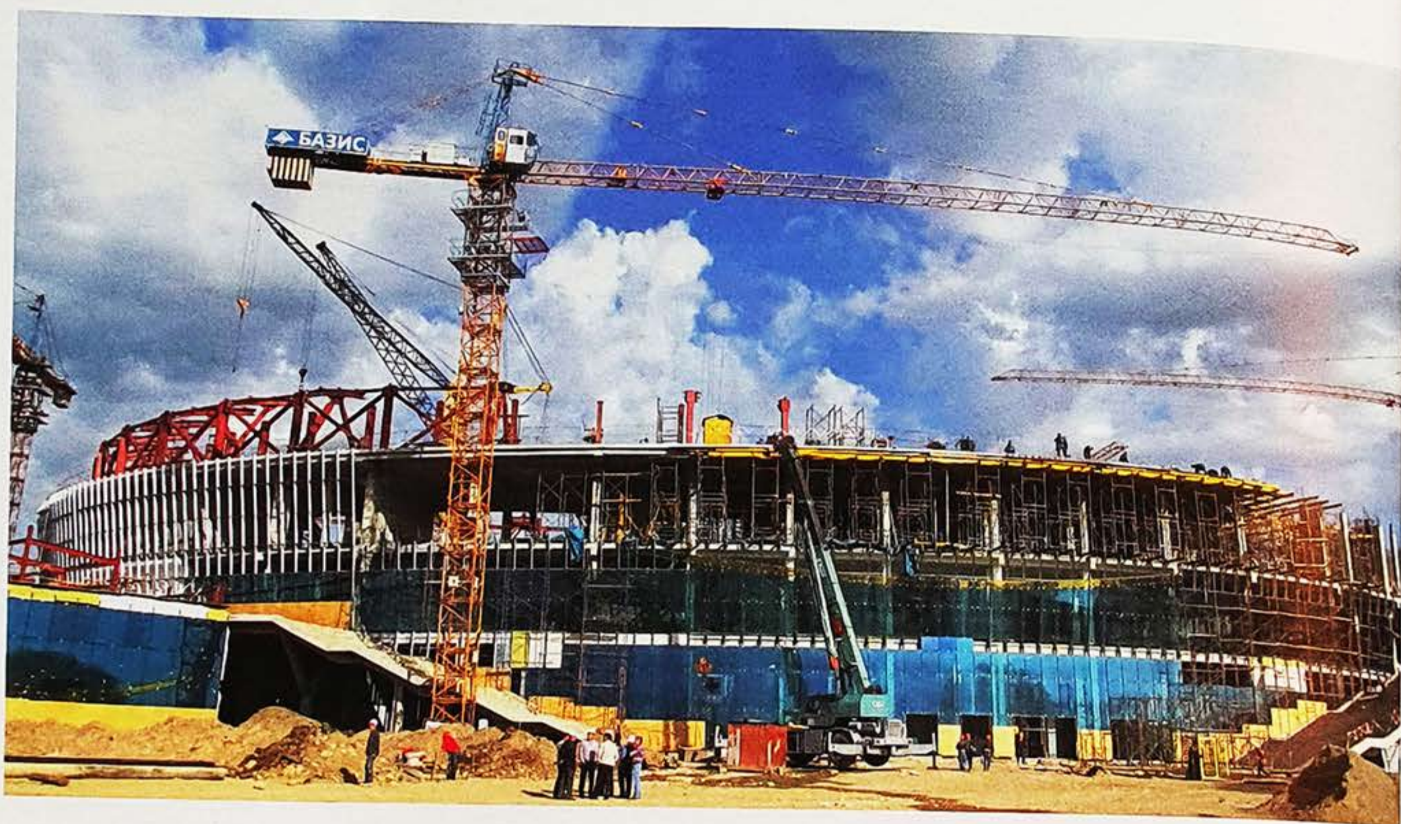
Рисунок 2 — Общий вид Блока А во время монтажа покрытия
